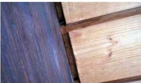
Abb.7: Möglicherweise nisten die Ameisen in Spalten unter der Deckenverkleidung
