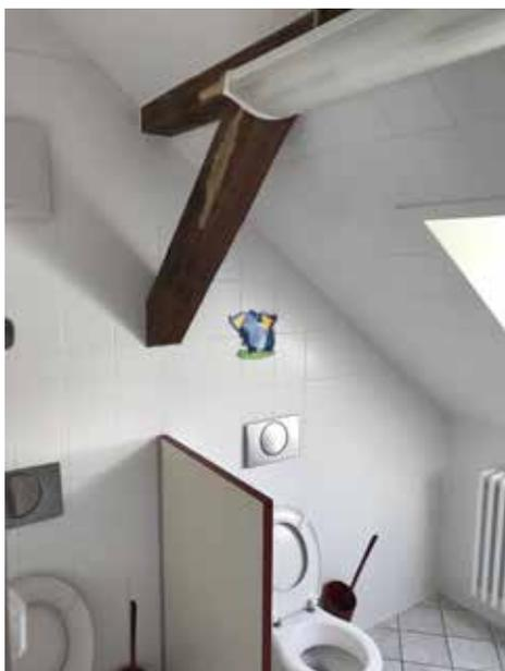
Abb.1 Schäden an tragenden Balken
