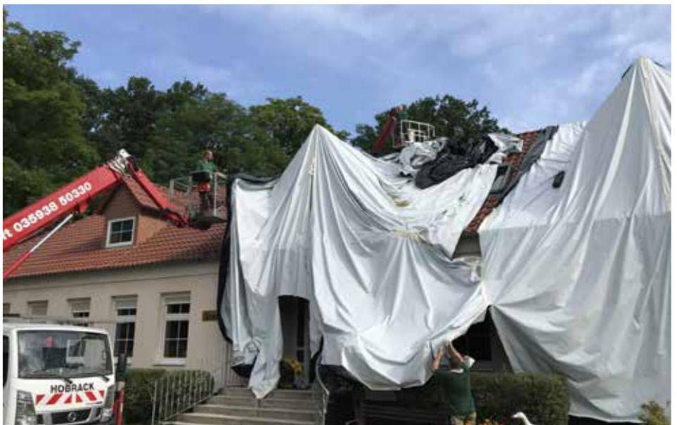
Abb.5 Rückbau der Folien mittels Hebebühnen
