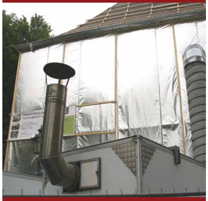
Abb.2 Hausschwammsanierung Halberstadt Heißluft 2012
