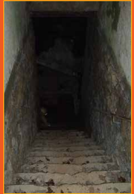
Abb. 7: Eine Treppe führt in einen unterirdischen, heute nicht mehr genutzten Wasserbehälter (Foto: Harbusch).
