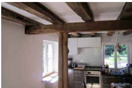
Abbildung 3: Nicht tragende Balken aus der Küche des begutachteten Odenwälder Hauses
