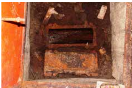
Abbildung 2: Massentwicklung wegen nicht verschlossener Revisionsöffnung
