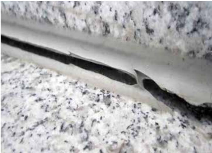
Abbildung 10: Detailansicht einer Silikonnaht im Treppenhaus
