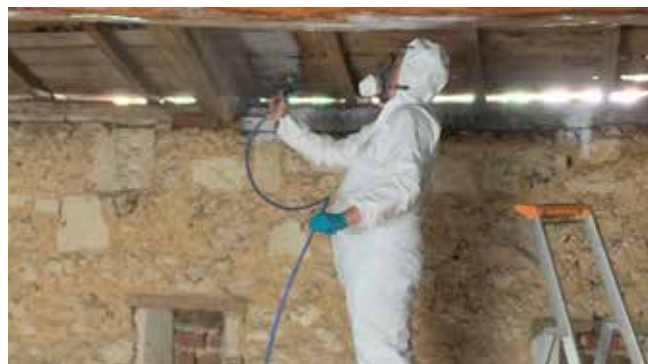
Praxisversuche auf einer Baustelle am Gebälk eines Dachstuhls.
