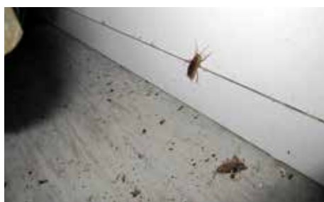
Abbildung 9: Unterhalb eines Heizkörpers in diesem Zimmer liefen zahlreiche Deutsche Schaben herum
