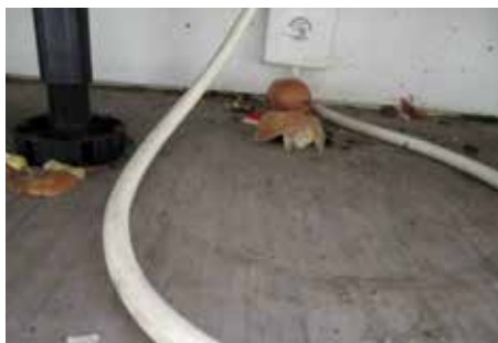
Abbildung 3: Essensreste unter einer der beiden Küchenzeilen
