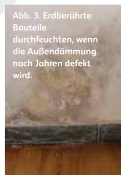
Abb. 3. Erdberührte Bauteile durchfeuchten, wenn die Außendämmung nach Jahren defekt wird.
