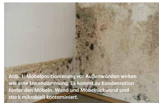
Abb. 1. Möbelpositionierung vor Außenwänden wirken wie eine Innendämmung. Es kommt zu Kondensation hinter den Möbeln. Wand und Möbelerückwand sind stark mikrobiell kontaminiert.
